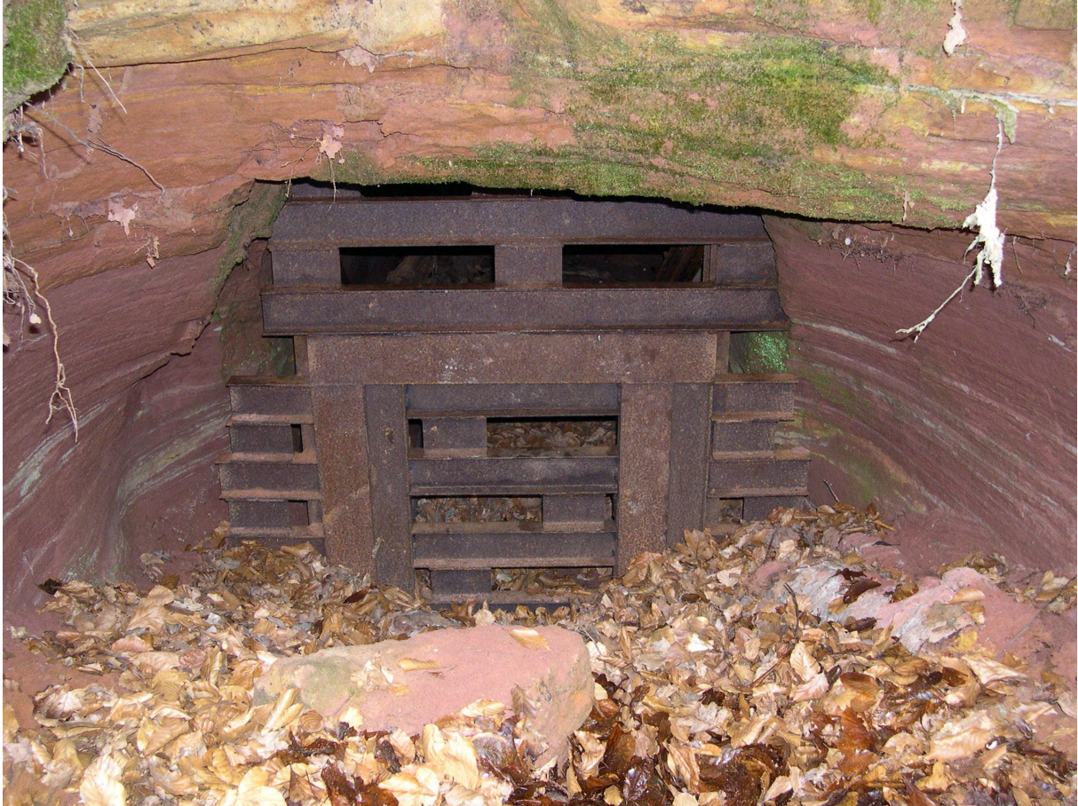
Abb. 2: Gittertor des Stollens Krötenbruch Foto: C. Harbusch, März 2011
