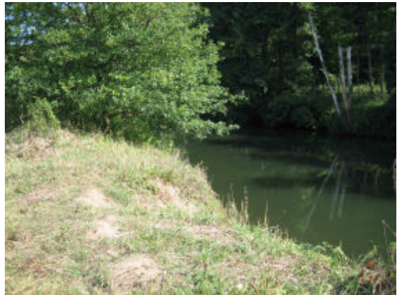
Offene, unverbusste Uferwälle begünstigen insbesondere innerhalb der Mäanderbögen die Seitenerosion bei Hochwasser und bieten im Sommer wärmeliebenden Kleinlebewesen Lebensraum.
