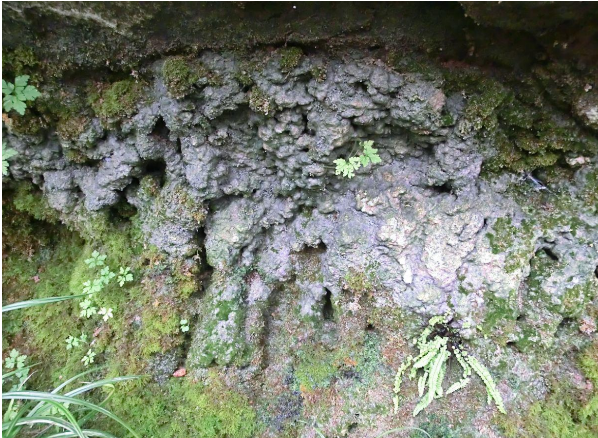
Abb. 13: Kleinflächige Kalksinterstrukturen am Oberen Felsenweg
