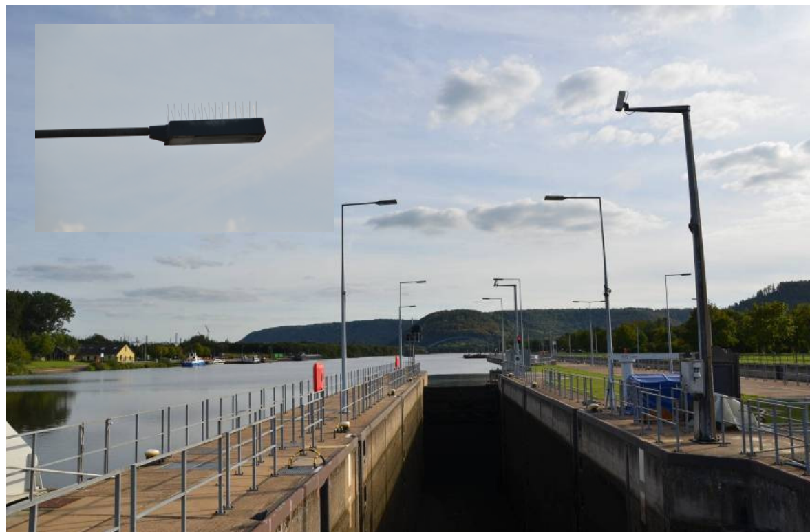
Durch das Anbringen von sogenannten Taubenspikes an Masten resultiert ein hohes Verletzungsrisiko für Wasservogelarten; Möwen oder Seeschwalben fliegen derartige Strukturen in Gewässernähe gerne als Rast- und Ruheplatz an (Staustufe Rehlingen, Sommer 2011).
