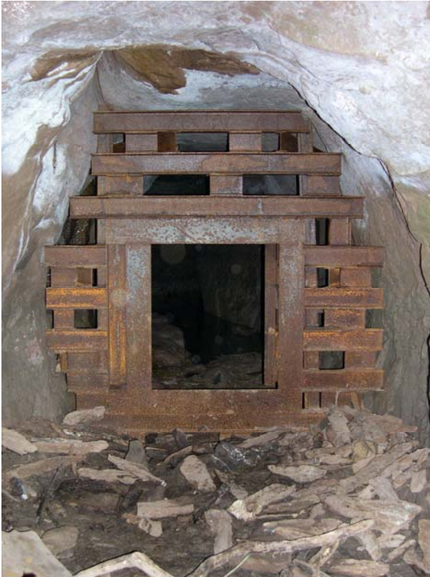
Abb. 2: Gittertür des Stollens Blauwald. Das Schloss ist aufgebrochen. Foto: C. Harbusch, März 2011
