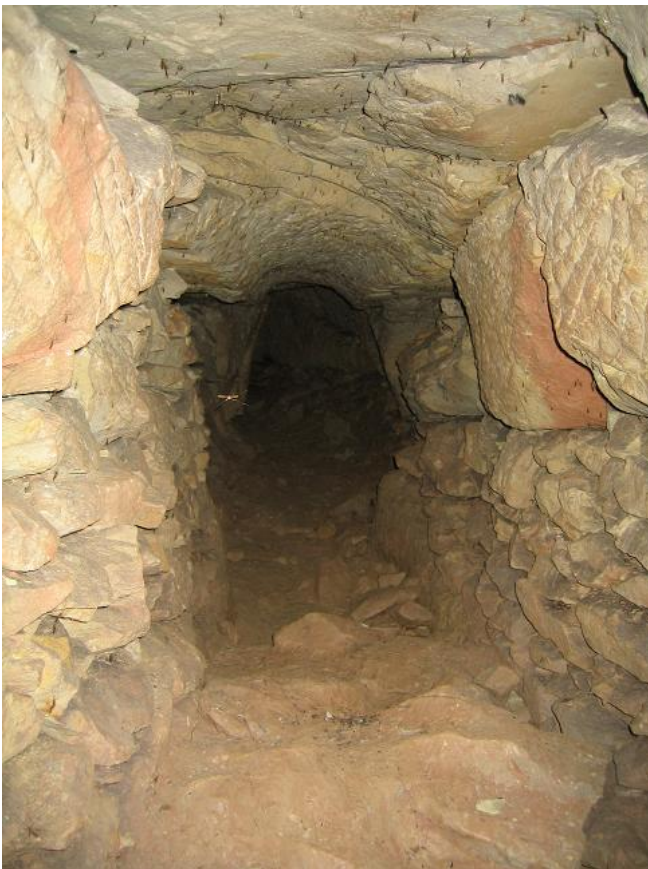
Abb. 3: Im Innern des Stollens Blauwald Quelle: http://www.uu-neu.de/
