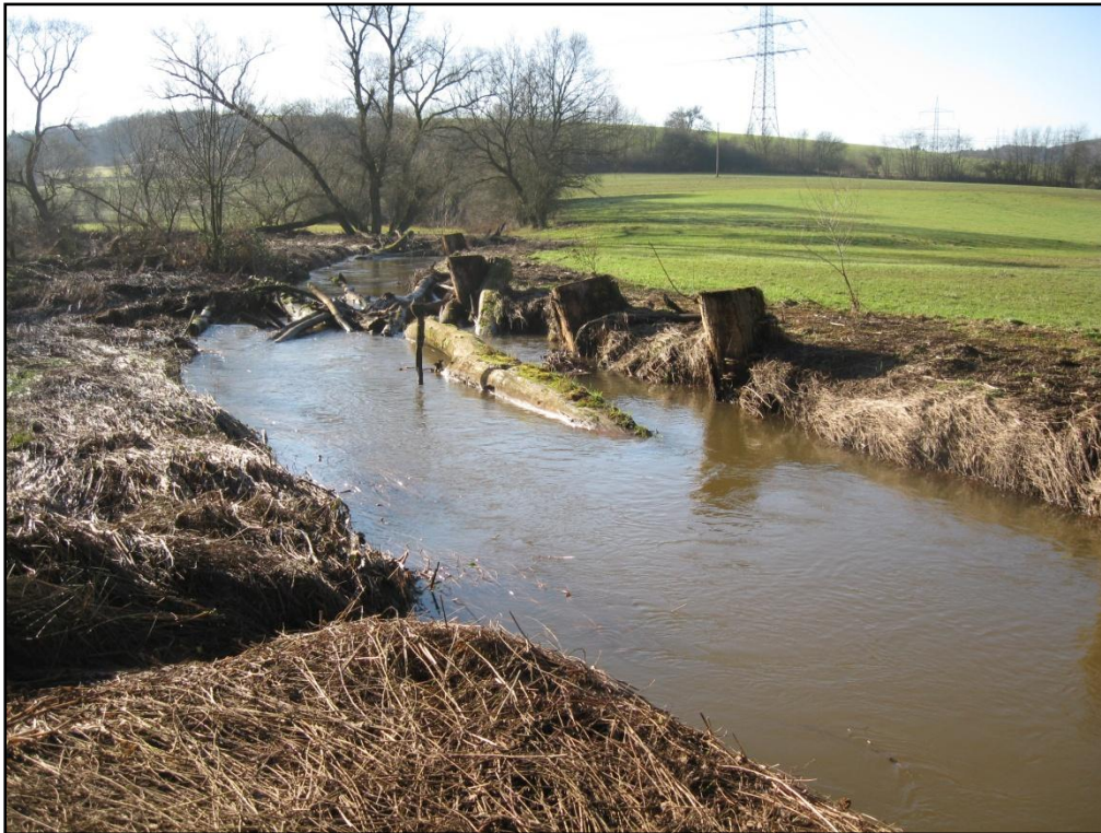
Foto 18: Förderung der Eigendynamik durch Einbringen von Totholz
