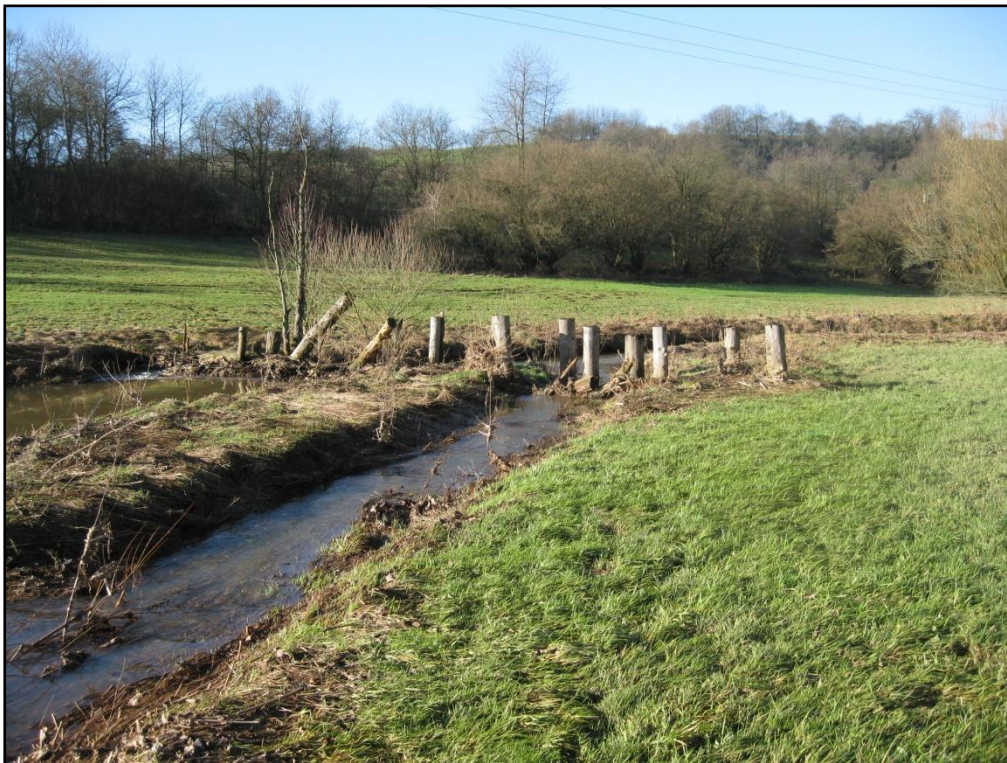
Foto 17 : ILL bei Wustweiler – Querverbau mit Pallisaden
