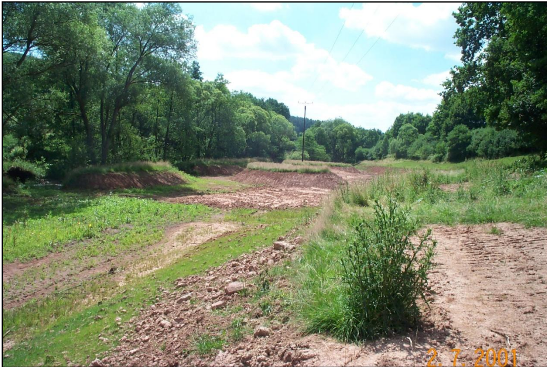
Foto 9: Beseitigung einer Aufschüttung und Anlage einer Flutmulde bei Eppelborn
