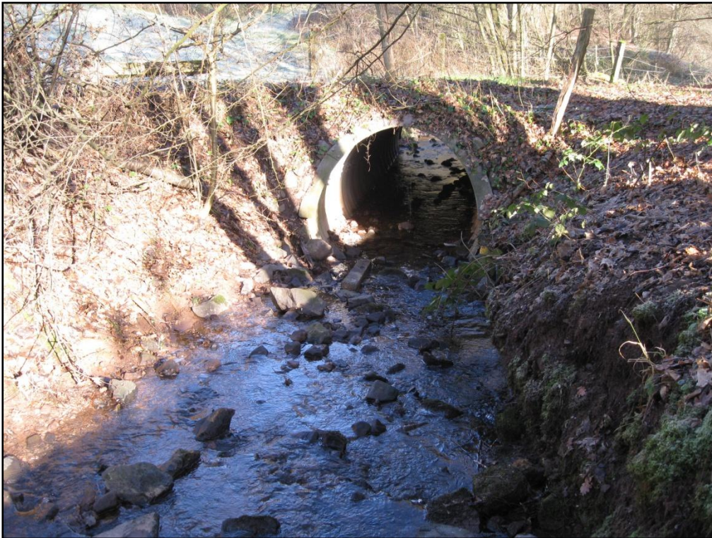
Foto 12: Durchlass am Ellmachersbach - keine Fische im Bach, periodisch trockenfallend, durchgängig für Makrozoobenthos
