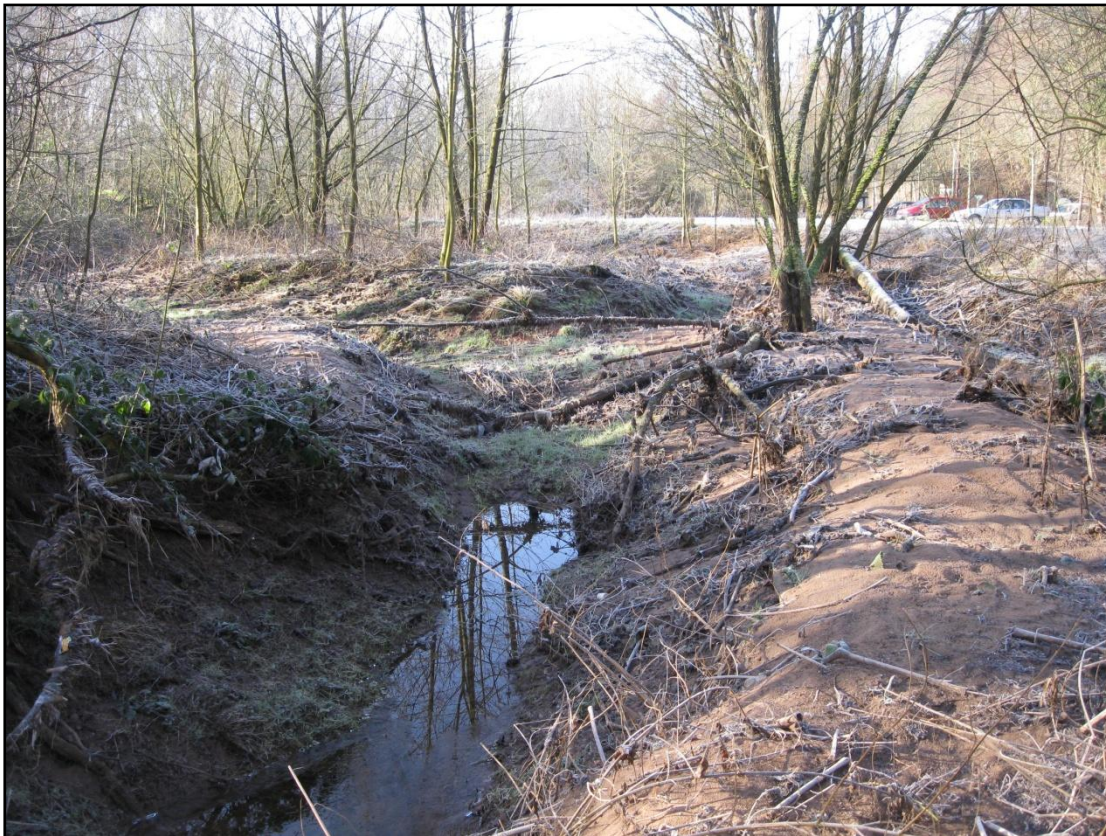
Foto 8: ILL bei Eppelborn, Beseitigung einer Aufschüttung und Anlage einer Flutmulde
