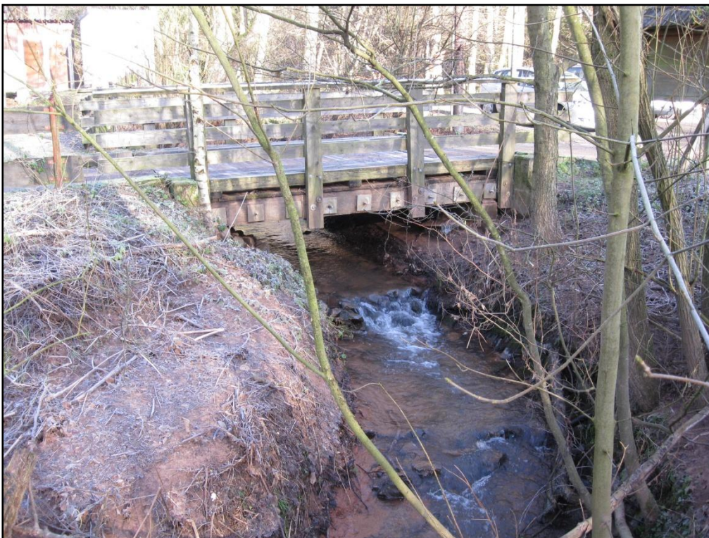
Foto 11: Brücke am Klingelfloß - für Fische durchgängig
