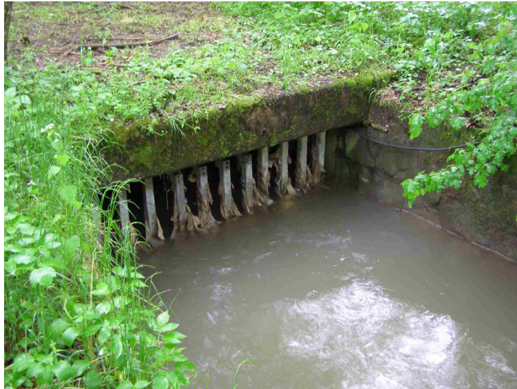
Abbildung 39: Einleitung von Schmutzwasser in die Prims bei Kastel
