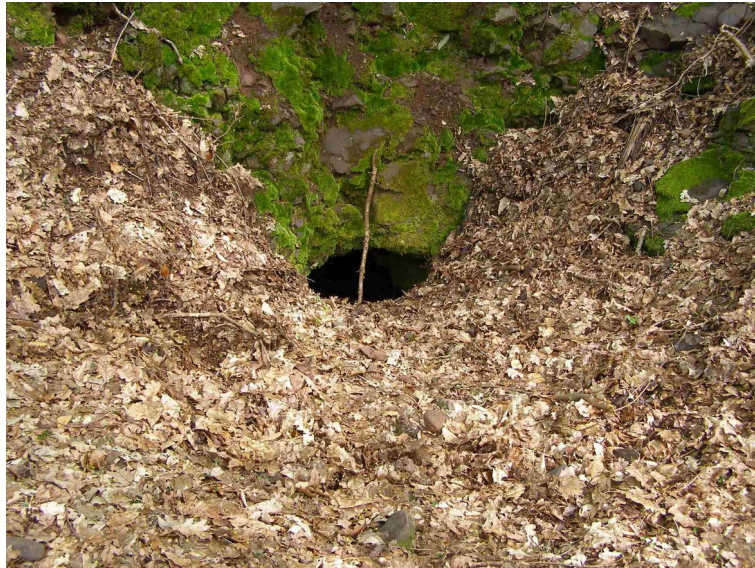
Abbildung 42: verfallener Stolleneingang oberhalb Büschfeld
