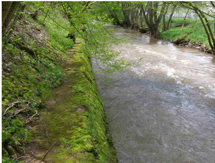
Abbildung 17: Uferbefestigung an der Prims bei Büschfeld
