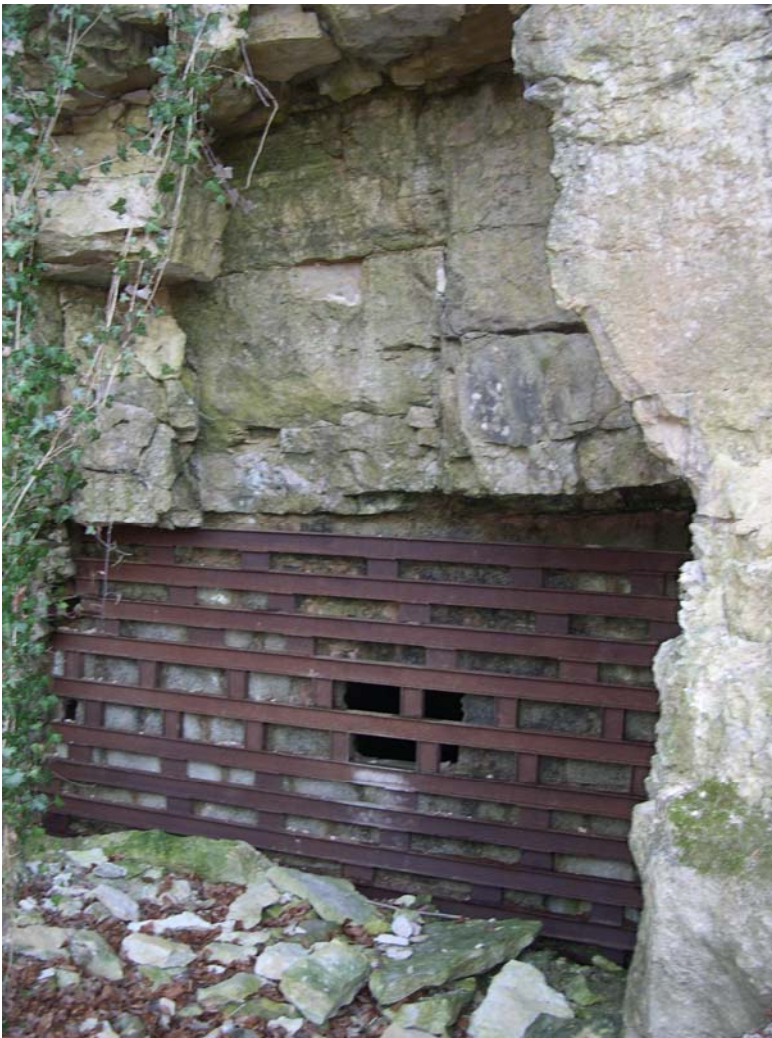
Abb. 1: Mundloch des Kalkbergwerkes Mondorf mit Vollgitter Foto: C. Harbusch, April 2011
