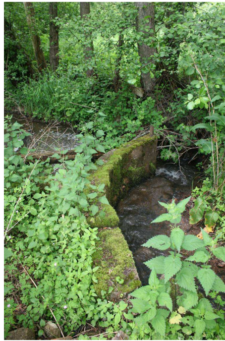
Abb. 10: Reste des Ausleitbauwerks
