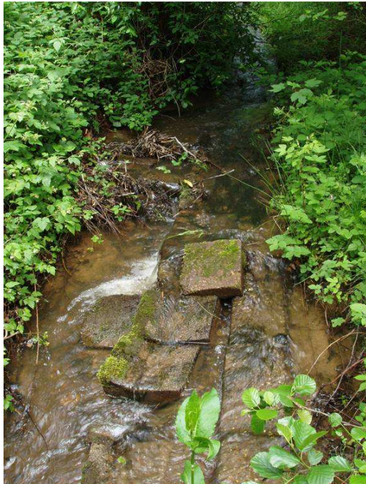
Abb. 9: Sohlverbau am Wellenbach
